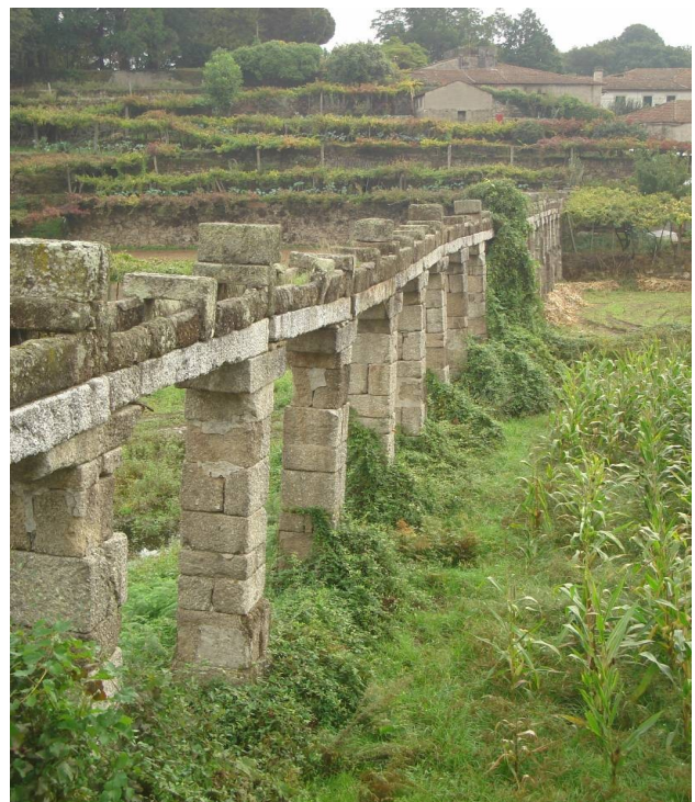
Imagem 5: Aqueduto Oitocentista do Vale do Mezio
